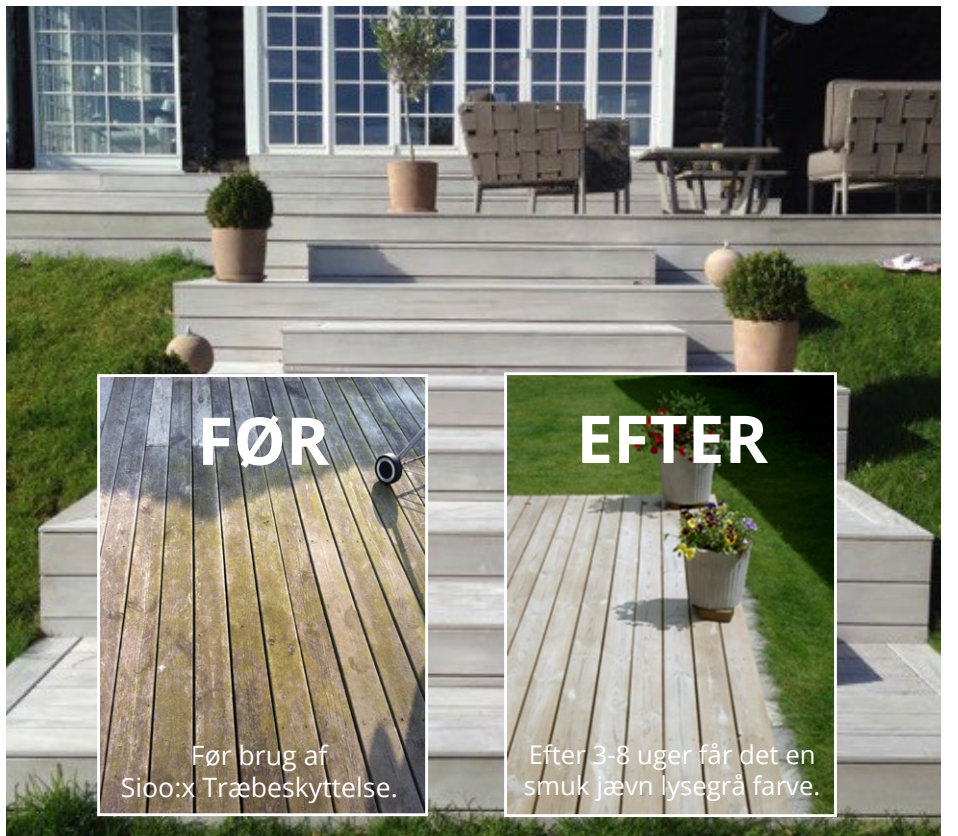
3.2: Den nyfærdigbehandlede overflade bliver i begyndelsen gul/brun. Ved senere kontakt med fugt, vil træet gradvist blive lysere.
