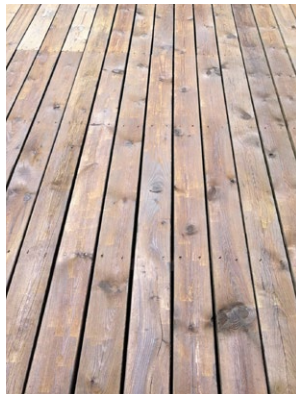
2.2: Sioo:x Træbeskyttelse Grunder påført.
